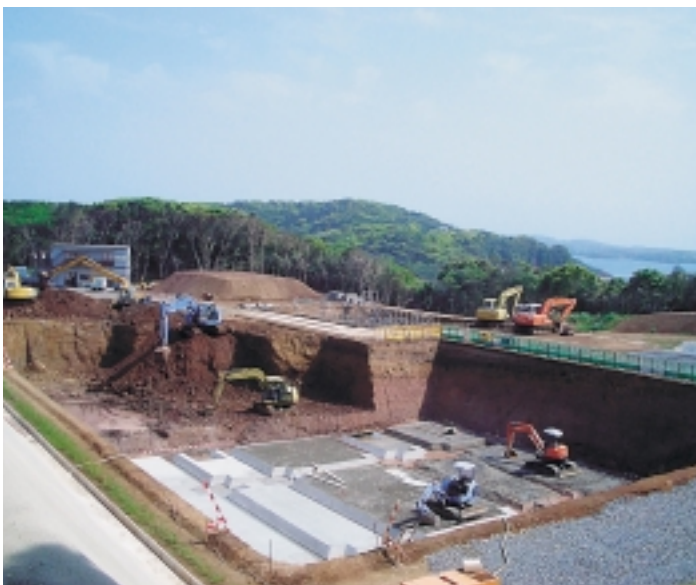
工事が進む勝本町自給肥料供給施設（勝本町本宮西触）
