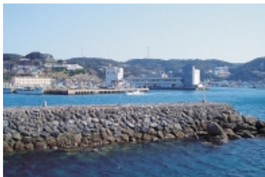
石積みの旧鵜ノ瀬の防波堤
