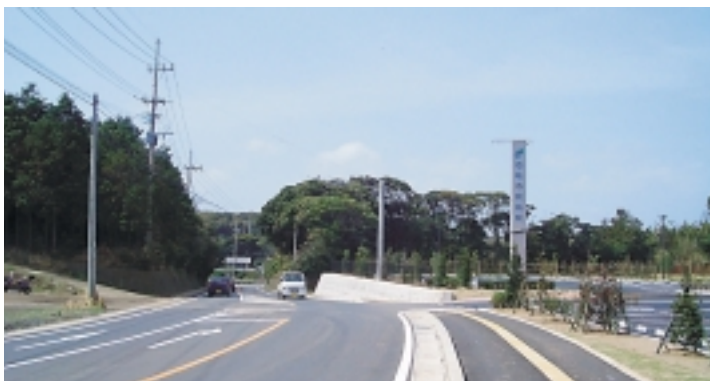
歩道が整備された市民病院前の県道
