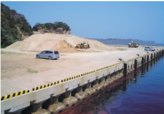
印通寺外港にある砂置き場
