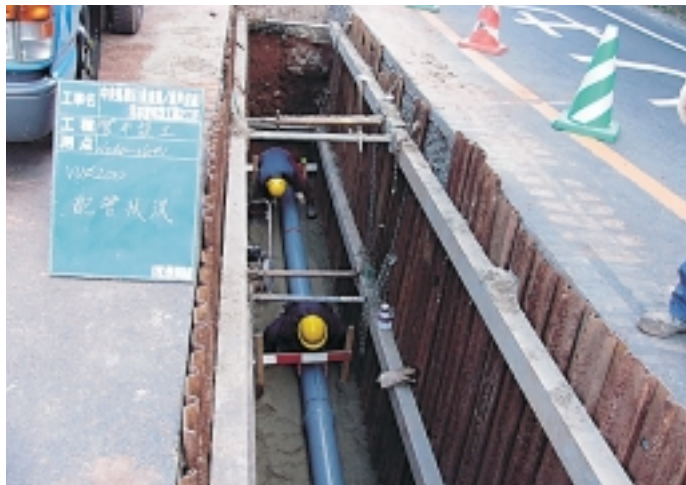
下水道工事の状況（県道郷ノ浦芦辺線）
