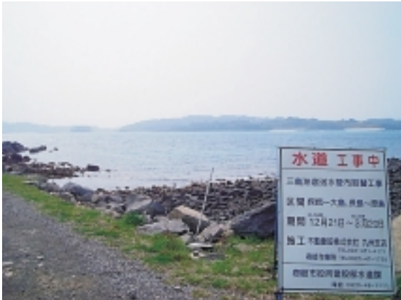
海底送水管布設替工事（嫦娥～三島間）
