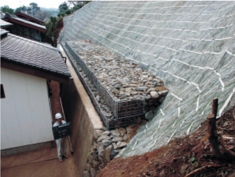
自然災害防止工事竣工写真（勝本町新城西触）
