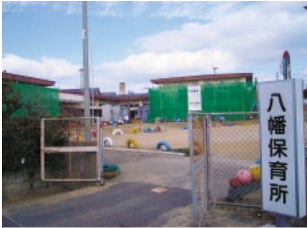
改修工事中の八幡保育所
