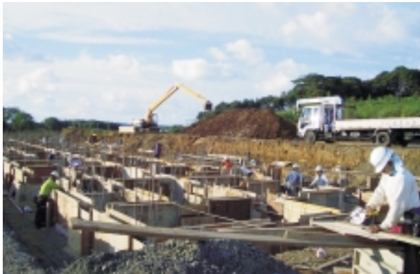
建設工事が進む今宮住宅（郷ノ浦町永田触）
