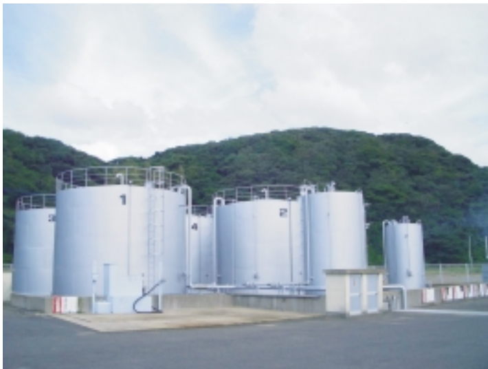
勝本町漁協石油備蓄基地（勝本町東触）
