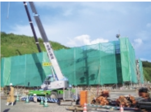
建設中の中央水処理センター
