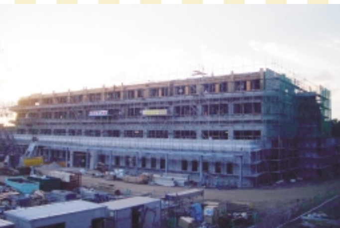
工事が進む新公立病院 (郷ノ浦町桜川地区)
