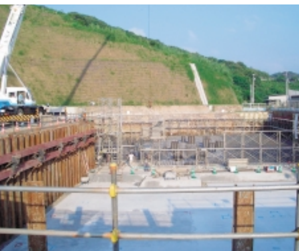
建設中の中央水処理センター（郷ノ浦町）
