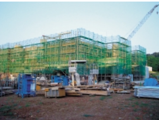
工事が進む吉岐公立病院（郷ノ浦町桜川地区）
