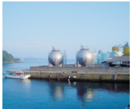
石油備蓄タンク(郷ノ浦町宇土湾)
