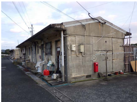
図 2-21 旧中尾団地 B 棟（昭和 43 年度建設）
