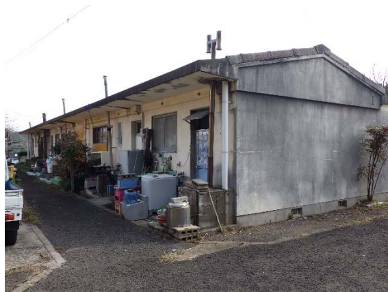
図 2-22 小崎団地 1 棟（昭和 43 年度建設）
