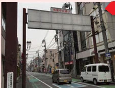
撤去されずに残されたアーチ看板
