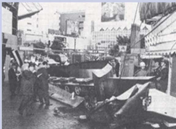
台風で落下した時の様子
