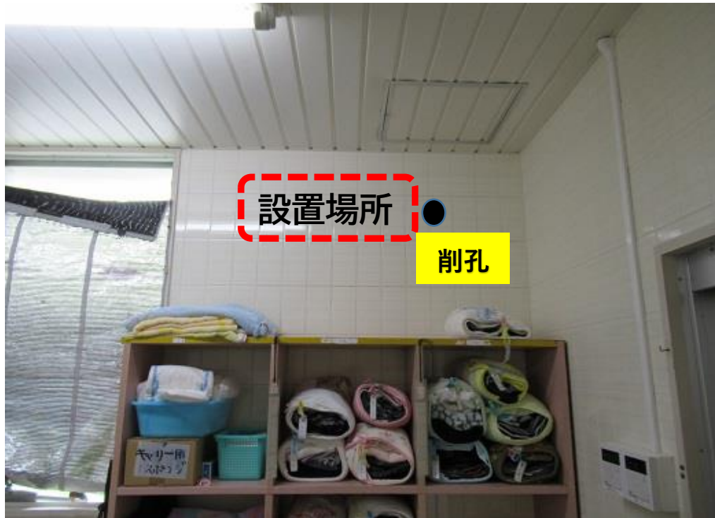
脱衣室設置場所
