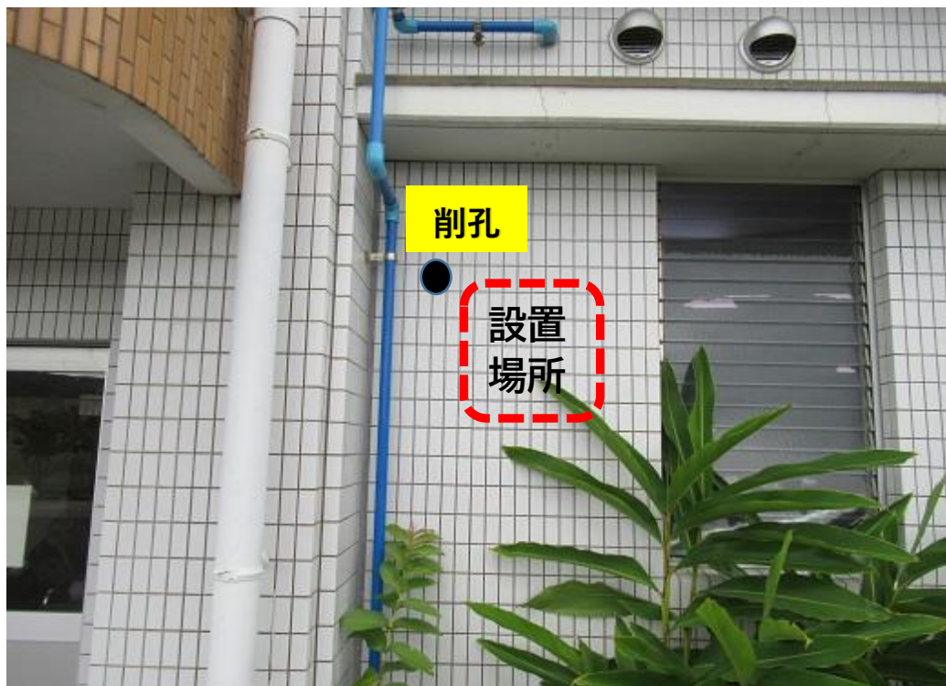
脱衣室室外機設置場所
