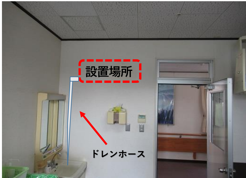
所長室設置場所
