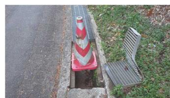
側溝蓋等の破損（例）
