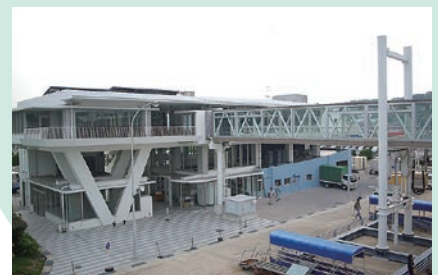
平成18年7月19日 芦辺港ターミナルビルリニューアル
