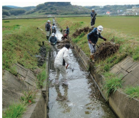
排水路の泥上げ作業
