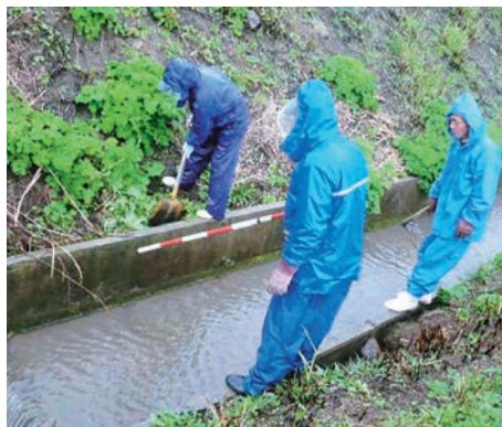
排水路の点検・管理
