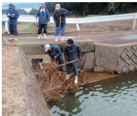
ため池の余水吐の清掃
