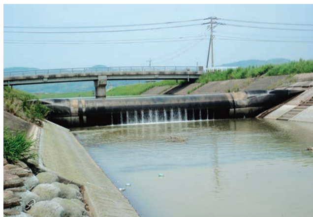
ラバー堰（風船ダム）
