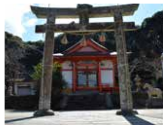
はちまん 八幡神社 【通称 箱崎八幡神社】 (芦辺町箱崎釘ノ尾触)
