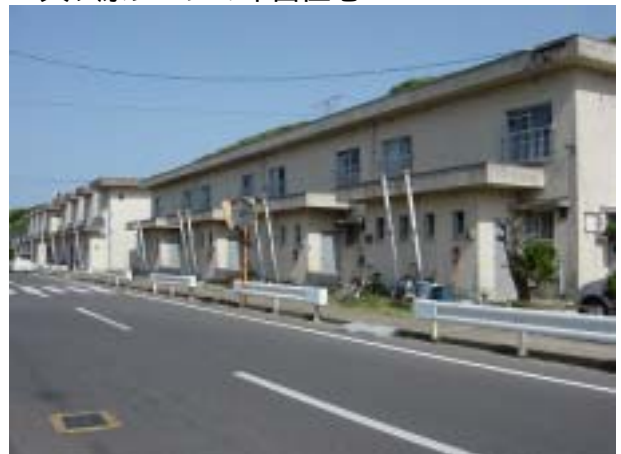
天ヶ原ゾーンの市営住宅
