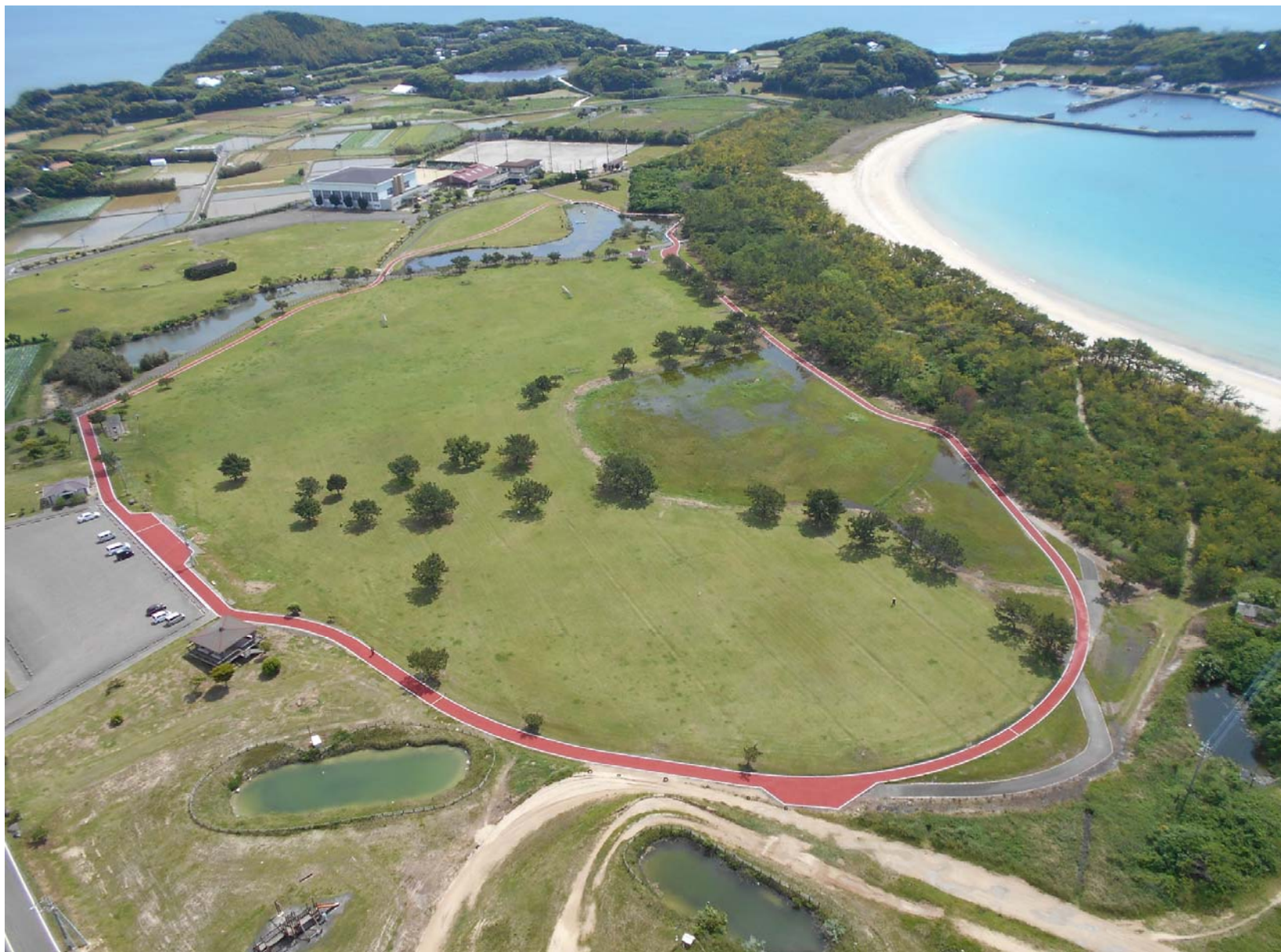
石田ジョギングコース設置工事
