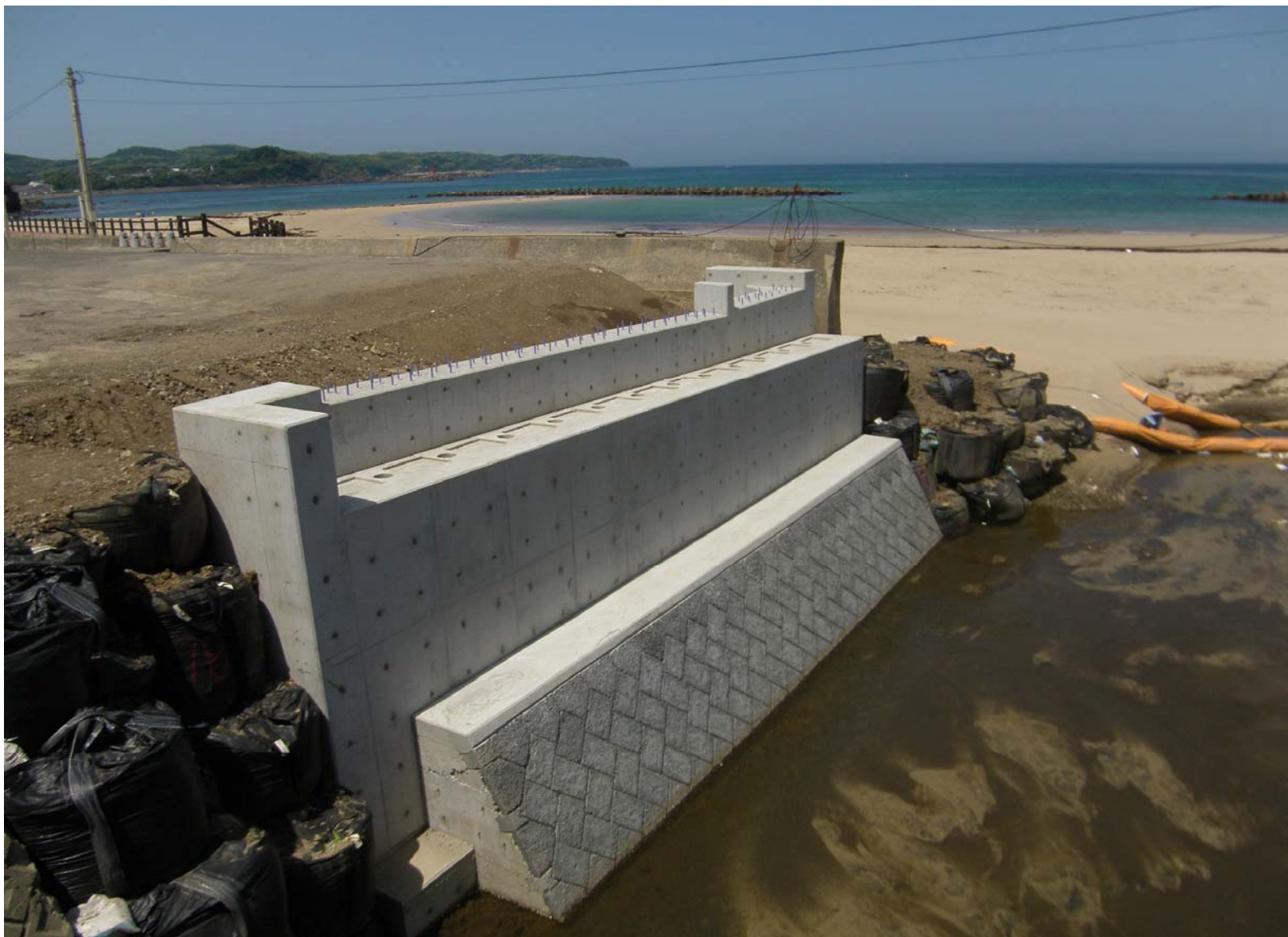
1級市道八幡芦辺線下部工工事(A1橋台)
