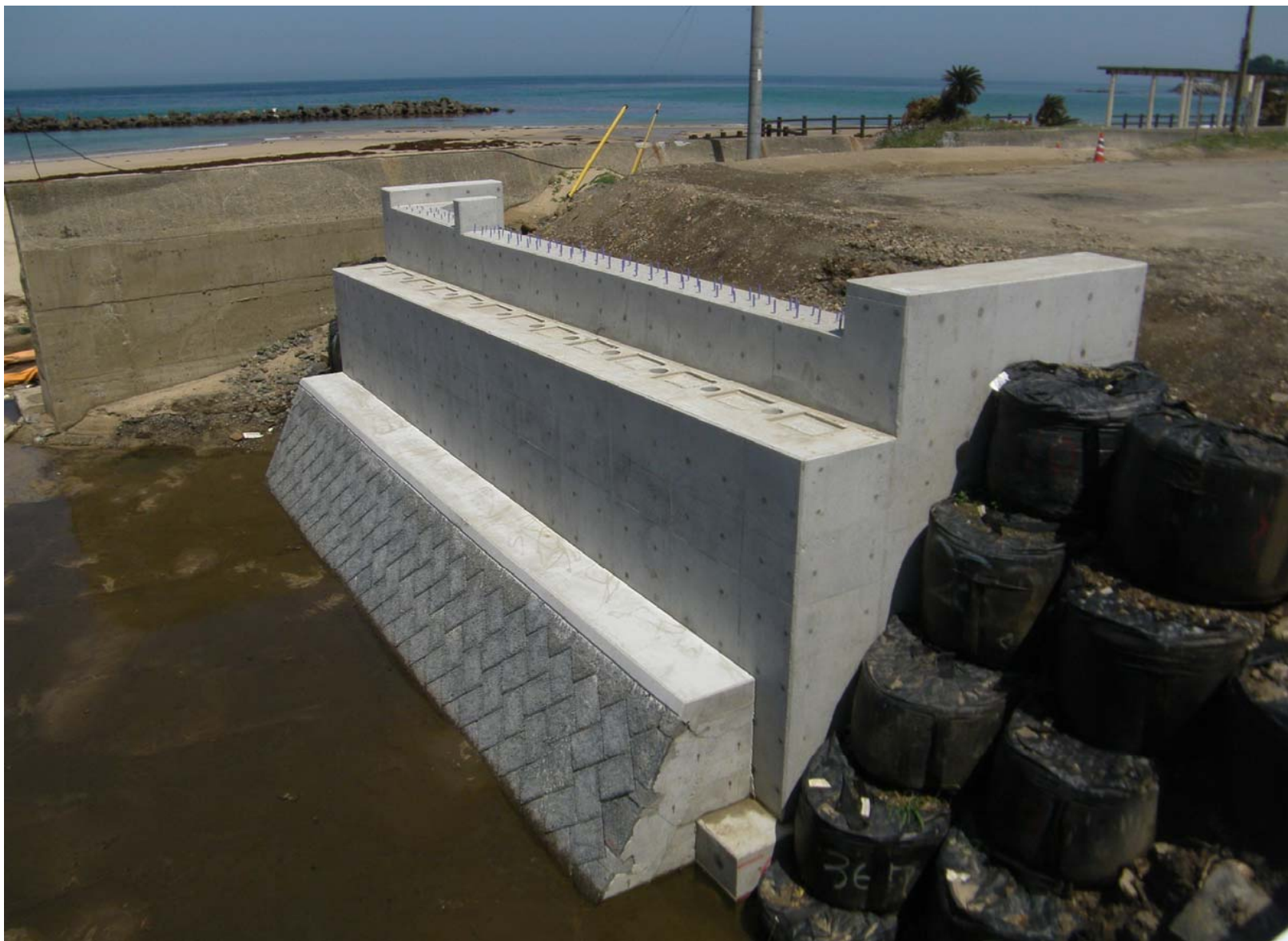
1級市道八幡芦辺線下部工工事(A2橋台)
