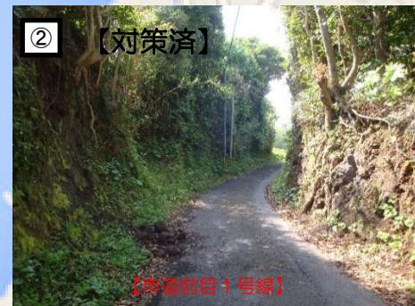
②道幅が狭く、道路沿いの法面が崩壊し落石等が多い。
