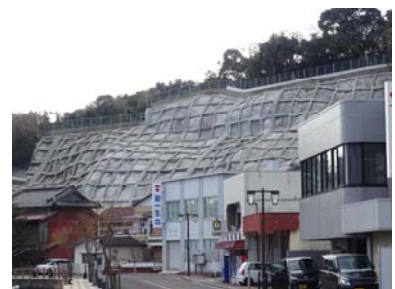
斜面の法面工事
